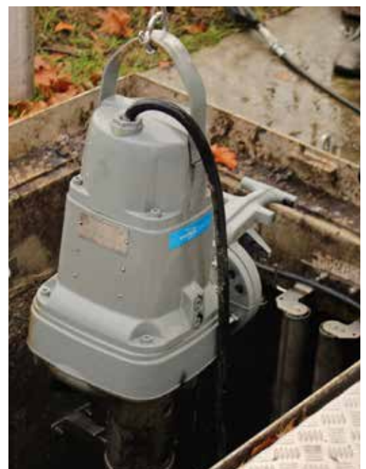
De plaatsing van de eerste Concertor in 'Gemaal De Moer'
