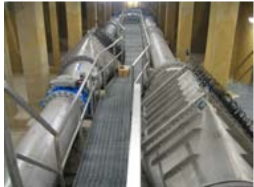
Detail: Installation Stockholm Vatten, water works Lovö II
