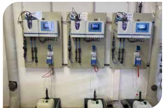
Drei Mess- und Regelsysteme DEPOLOX Pool Compact
