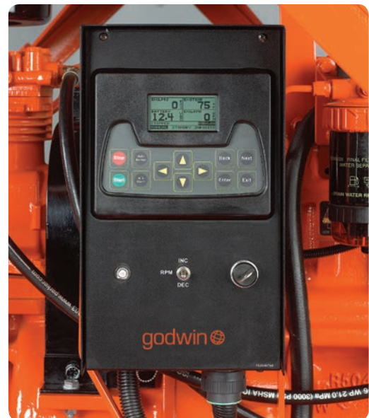
PrimeGuard kan fås som tillval för alla Dri-Prime-pumpar i CD- och HL-serien med dieselmotoreffekter över 140 kW.
