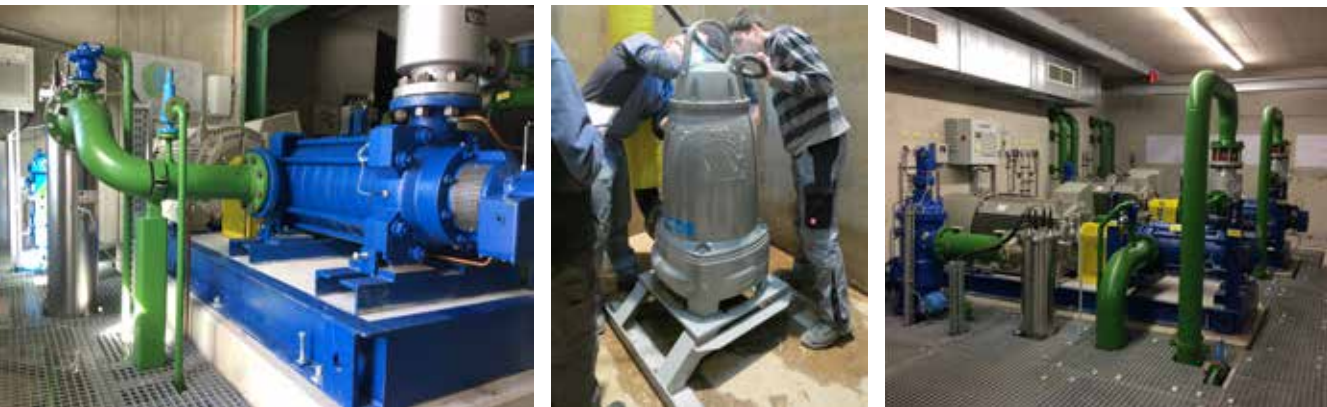
Fördermenge bis zu 180 m³/h, Förderhöhe bis zu 790 mWS
