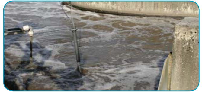
In der Belebung: Kalibrierfreier Sauerstoffsensor FDO® 700 IQ F
