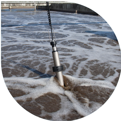
(Sensorhouder EH/U 170 in combinatie met zwenkmontageset EH/F 170-1,5)
