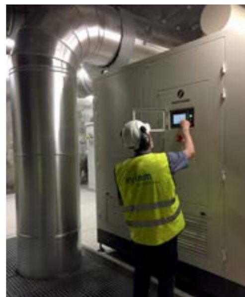
Dipendente Xylem assiste durante l'avviamento di un soffiante TurboMAX 600 (400kW).
