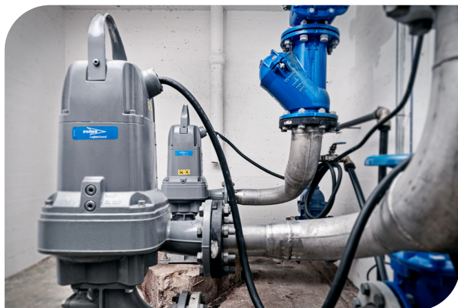
Flygt Concertor 6020-pumpar med Adaptive N-hydraulik i en pumpstation för kommunalt avloppsvatten
