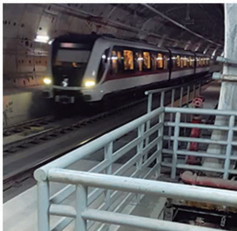
Cárcamo de instalación de bomba a pie de vía.
