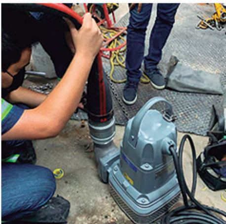
Flygt Bibo ® (Alpha) es liviana y no necesita grúa para su instalación.
