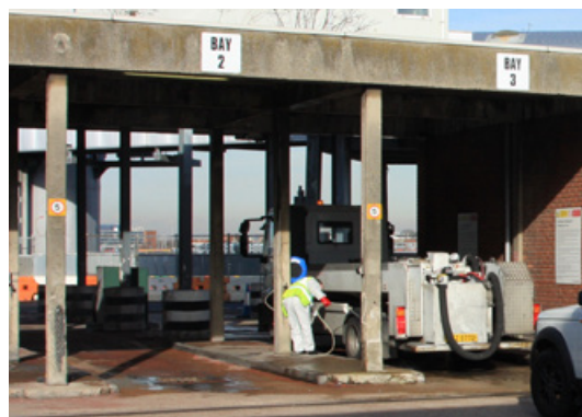
Véhicule de déchargement des eaux usées des avions d'Heathrow, transportant les eaux usées au poste de relevage principal situé à côté du Terminal 1.
