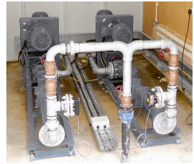
Transporte de aguas residuales sin tratar de una instalación doméstica
